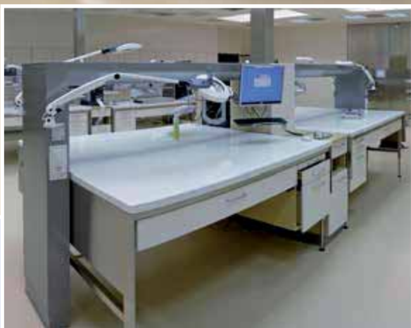
Tischüberbau für Medienversorgung, Lupenleuchte und Monitor*
